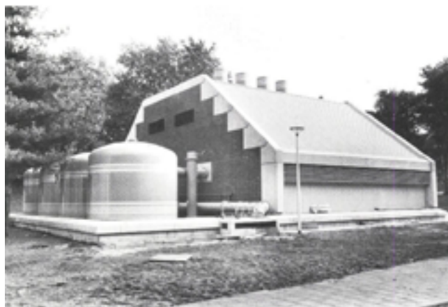
Figuur 1 - Renovatie waterpompstation 1984 - (A.L. Fleurkens, 1985)
